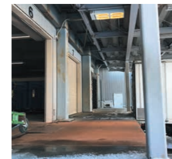
■ トラックヤード
