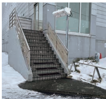
■ エントランス階段
