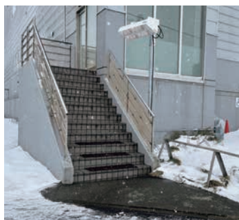
■ エントランス階段
